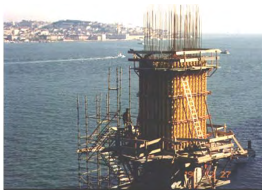
Aspecto da cofragem trepante para a betonagem da torre.
