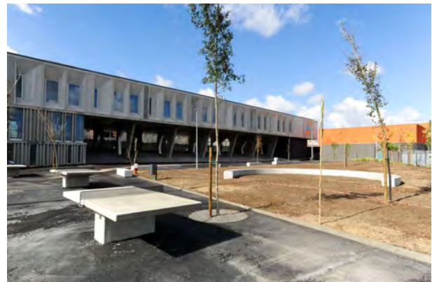
Vista geral dos edifícios da escola
