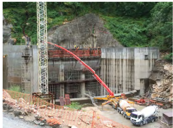
Trabalhos na zona Restituição Albufeira da Caniçada
