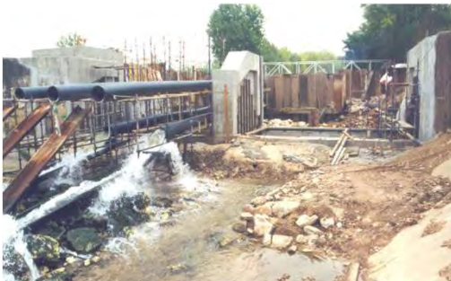
Açude do Arrabalde: rio a escoar apenas nos tubos inferiores, durante a execução da obra
