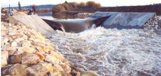
Açude das Salgadas: vista de jusante da margem direita (açude a descarregar com o insuflável a esvaziar)
