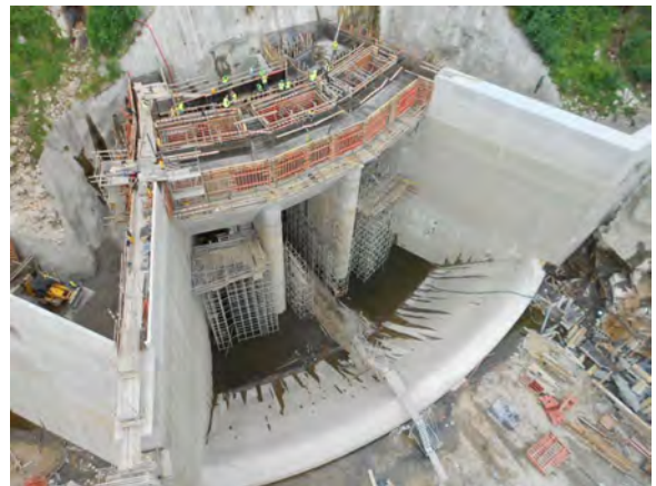
Trabalhos na zona Restituição Albufeira da Caniçada
